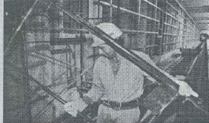
Los operarios instalan paneles acústicos en los laterales de las vías para evitar ruidos molestos.
